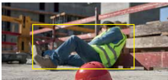
선박·해양 플랜트 스마트 야드와 전기 설비공사 현장 위험 상태 판단 데이터 구축
